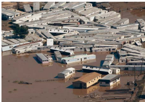
Vom Hochwasser weggeschwemmte Mobilheime.
