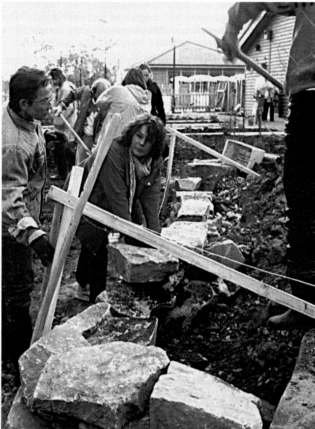
Aufschichtung von Natursteinen zu einer Stützmauer: Hinter den Steinen muß als „Dränage“ Lockergestein eingebracht werden. Wärmeliebende Tiere wie die Zauneidechse (Bild rechts) finden hier Unterschlupf.
