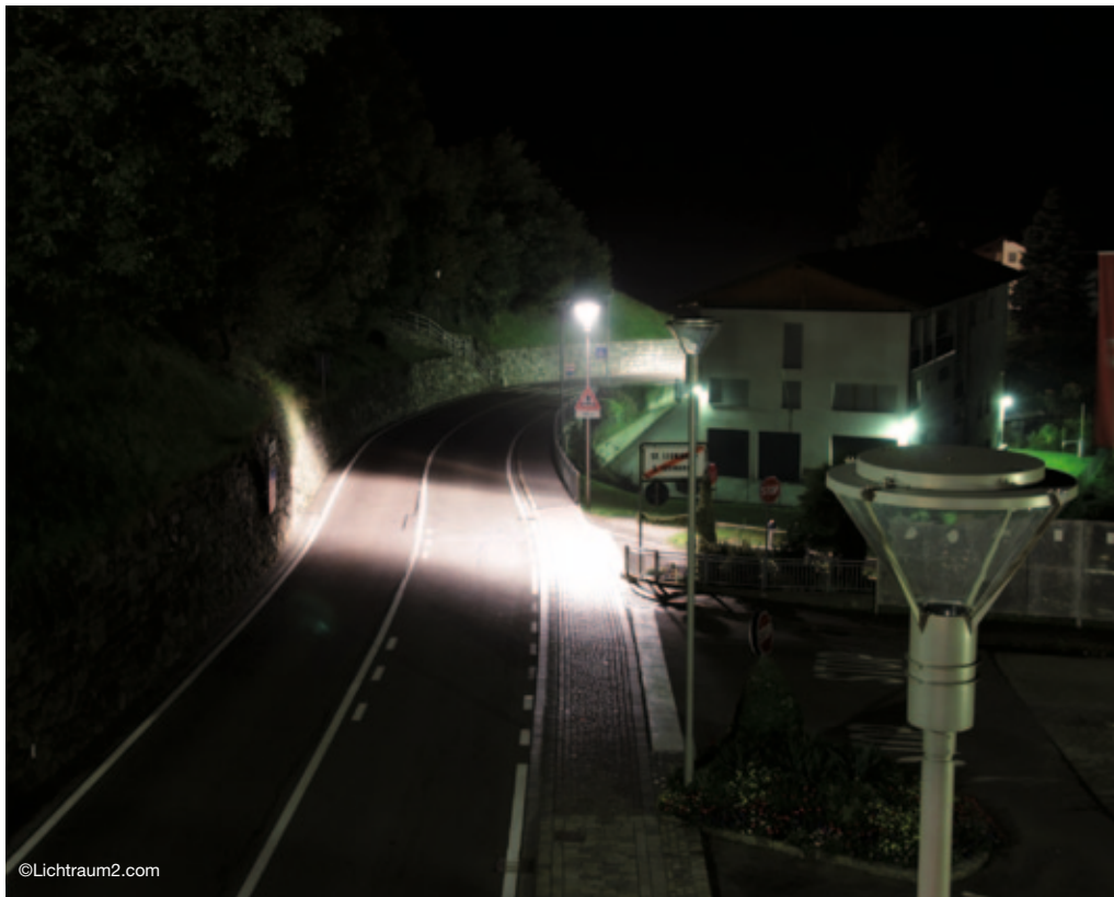
Abbildung 7: Alternierendes Abschalten von Straßenleuchten
