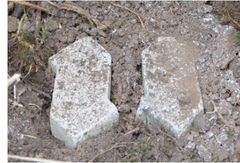
2 Steine und Leisten unter dem Kasten sorgen dafür, dass von unten keine Feuchtigkeit hochkommt
